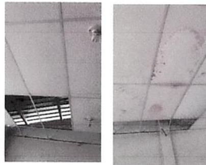
Foto 6: Cambio de cielo falso en salón de clases.
