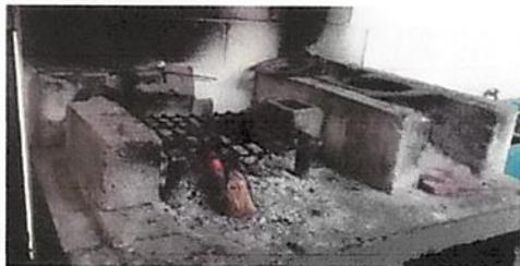
Foto 5: sustitución de polletón por estar en mal estado.
