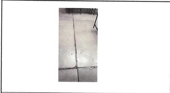
Foto 1: cambio de torta de cemento por piso cerámico.
