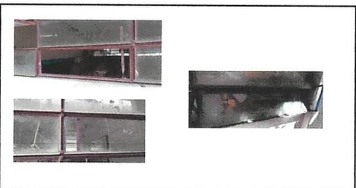
Foto 6: Ventanas en mal estado, falta de vidrios en algunas.
